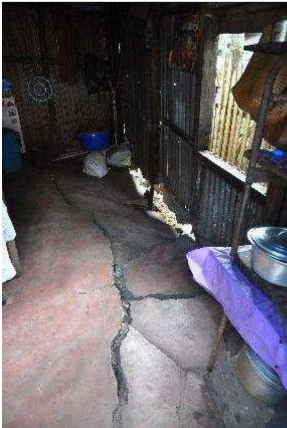
Le sol en béton est partiellement effondré et la toiture ne tient plus qu'avec des bois complètement pourris !
